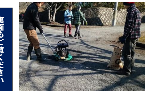
ボランティアによる認定外道路 修繕作業
