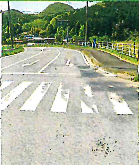
八田井尻線(井尻) L=10m、W=5m 工事費=800千円
