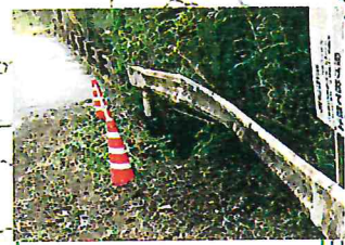
升谷大迫線(升谷) 法面工 L=5m C=800千円
